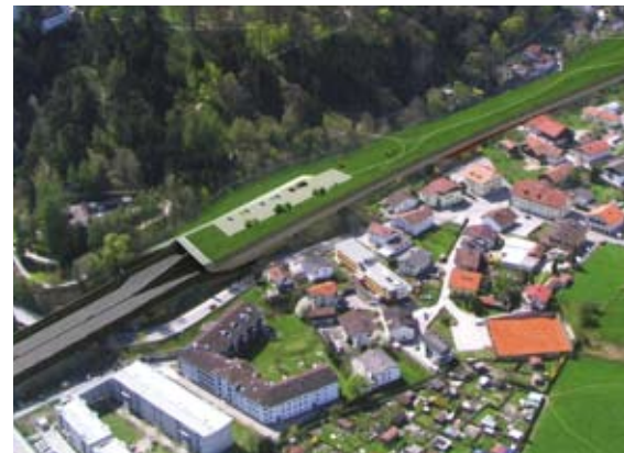
Baustelle A12 Inntalautobahn (Foto: Asfinag)
