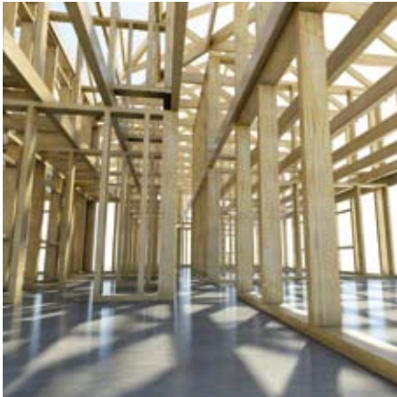
Holzrahmenbau mit Allplan und den neuen Modulen.
