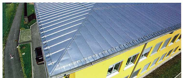
Neubau Technologiezentrum inneres Salzammergut (Bandblech Alu beschichtet)
