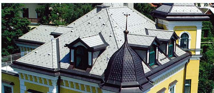
Renoviertes Villendach im Salzammergut (Eternit Dachschildel und Kupfer)
